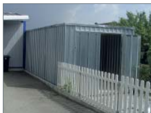
SBH26 – an bestehende Garage angestellt
